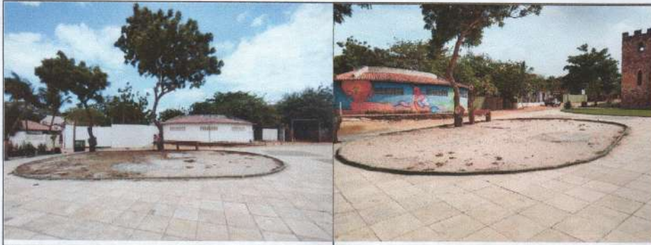
Área de canteiro que será colocado piso intertravado Área de canteiro que será colocado piso intertravado
