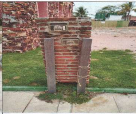
Demolição da alvenaria do quadro de medição
