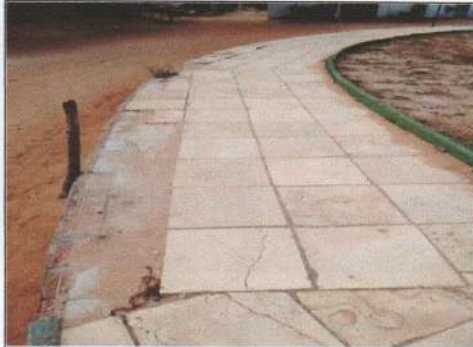
Recuperação do piso em pedra cariri e meio fios
