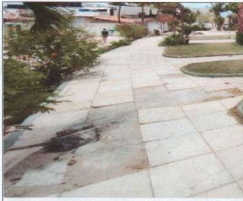
Recuperação do piso em pedra cariri
