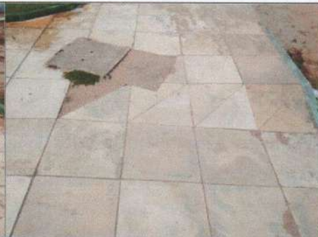
Recuperação do piso em pedra cariri
