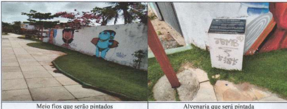
Meio fios que serão pintados Alvenaria que será pintada
